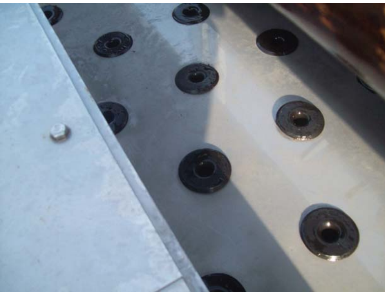
Plateau de distribution : Après le nettoyage
