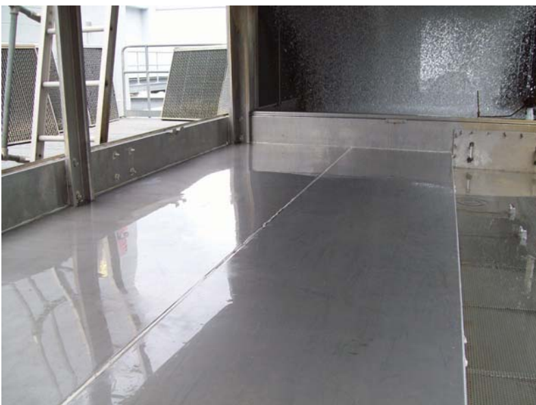
Bassin de tour de refroidissement : Après le nettoyage
