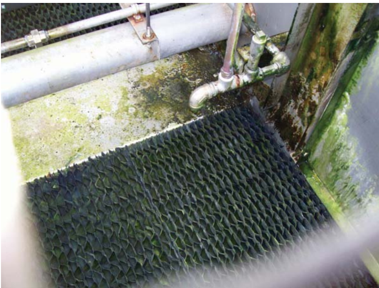
Bassin de tour de refroidissement : Avant le nettoyage
