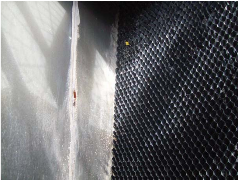
Remplissage de tour de refroidissement : Après le nettoyage
